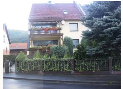
Wilhelmshausen, die Balkone und die großen Fenster gab es aber noch nicht
